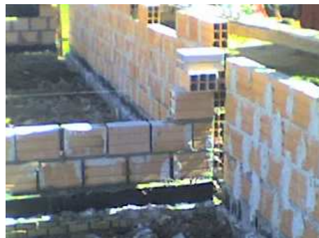
Construção da escola
