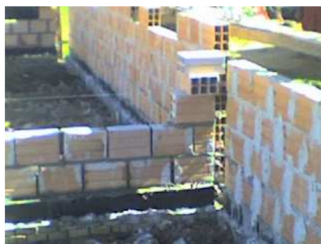
Construcción de la escuela
