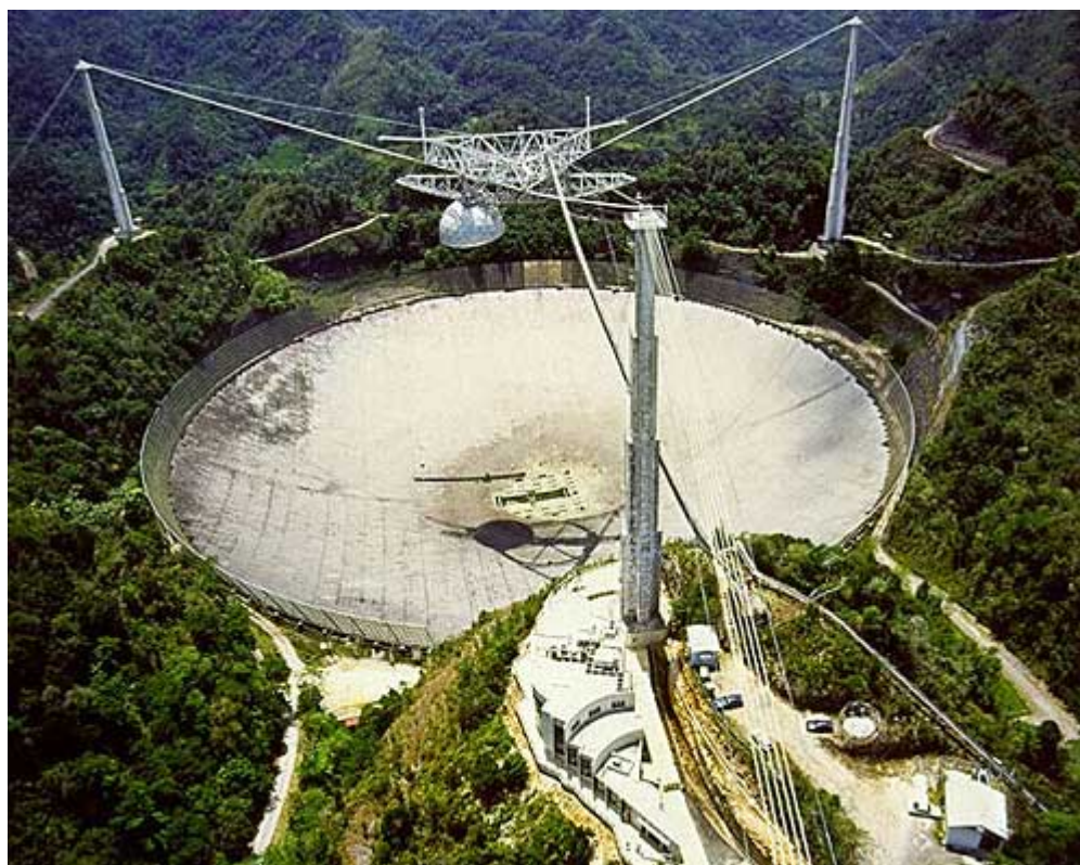
Fig. 4. Radiotelescopio de Arecibo, Puerto Rico. La superficie del instrumento posee un diámetro de 305 metros. Para mayor información visitar el sitio http://www.naic.edu
